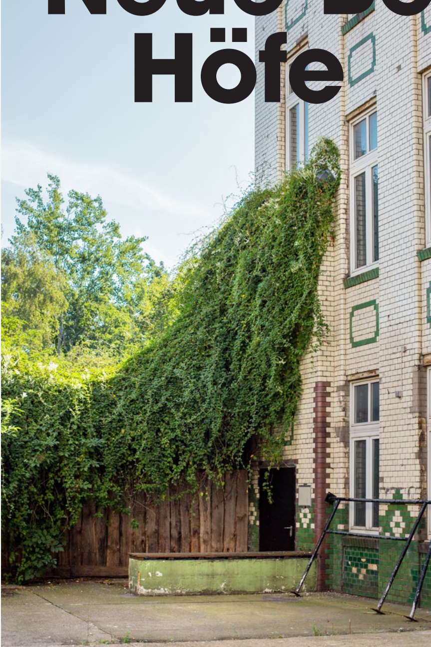
Foto: The PettCo Bestandsgebäude vor der Sanierung
