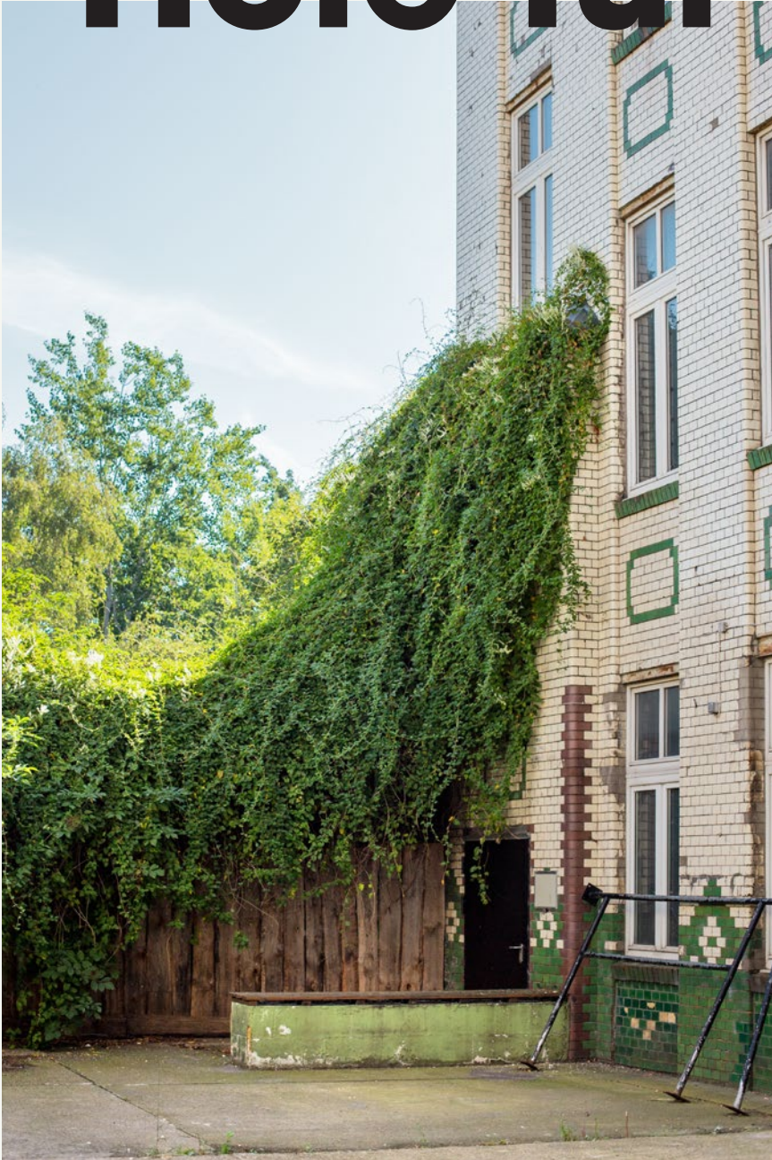
Foto: The PettCo Bestandsgebäude vor der Sanierung
