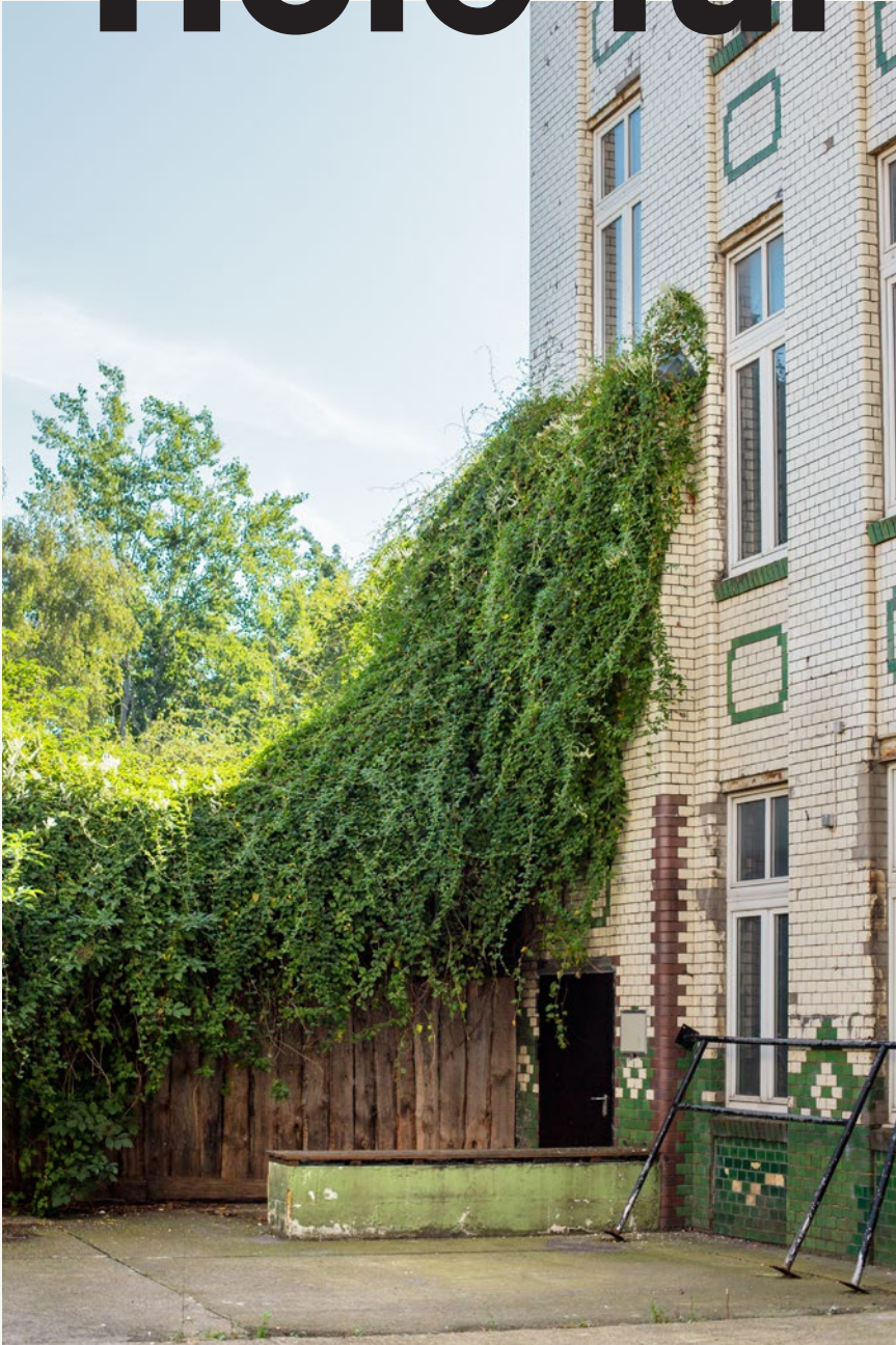
Foto: The PettCo Bestandsgebäude vor der Sanierung
